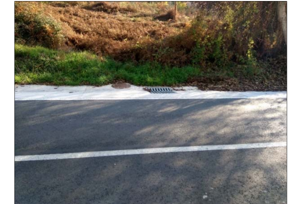
Foto 2. Arqueta cruce existente. P.K. 2+330
