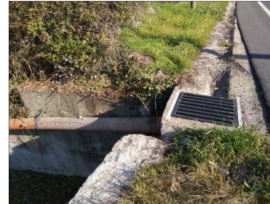
Foto 1. Sumidero con vertiente de aguas P.K. 1+810
