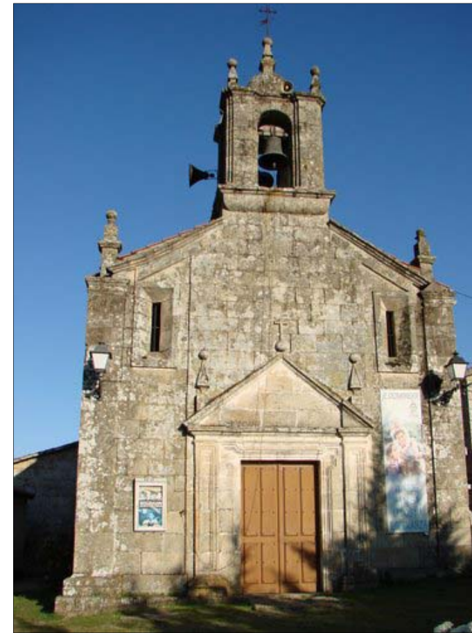
Foto 2. Fachada de la iglesia
