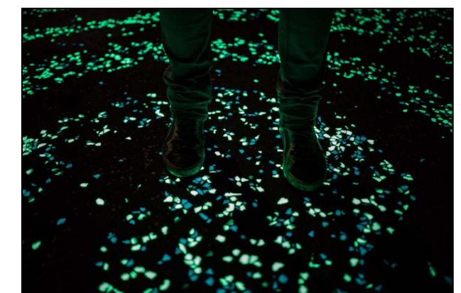
Foto 2. Detalle del pavimento fotoluminiscente.
