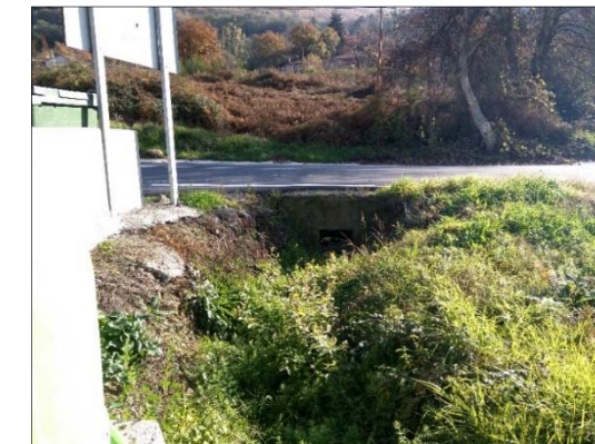
Foto 3. Salida de cruce existente (tajea) - P.K. 2+330
